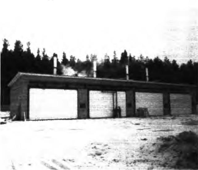
Рис.1. Сушильные камеры с фронтальной загрузкой пиломатериала
