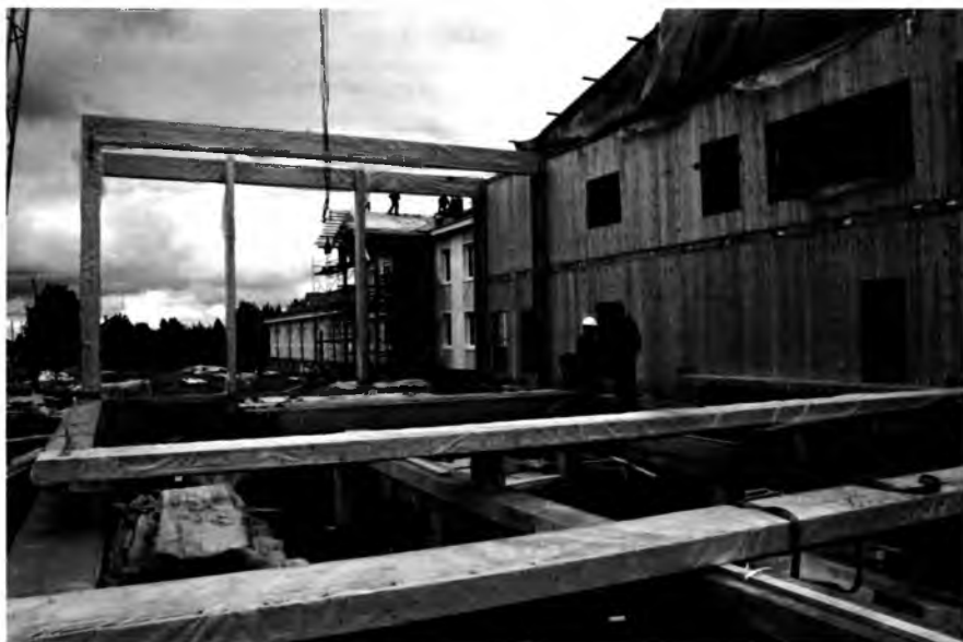
Рис. 2. Монтаж несущих конструкций спортивного зала
