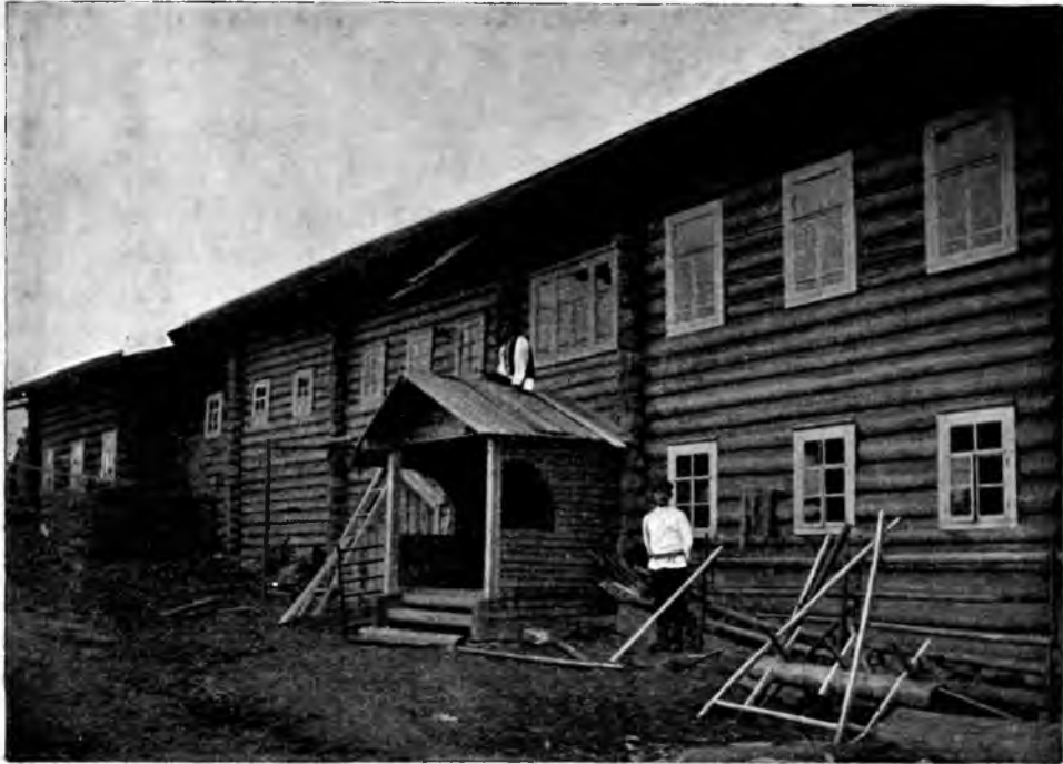
Рис. 12. Боковой фасадъ дома.
