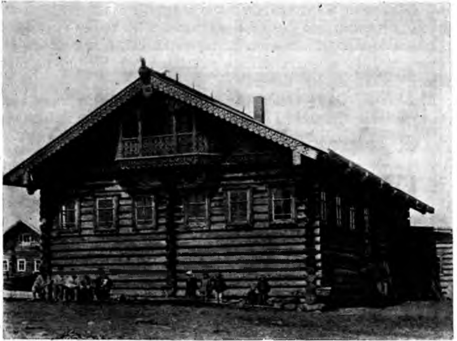
Рис. 30. Наружныя украшенія столбики и птицы на охлупнѣ, рѣзба на балконѣ подзорахъ и окнахъ. (С. Шангалы, Вельск. у.).
