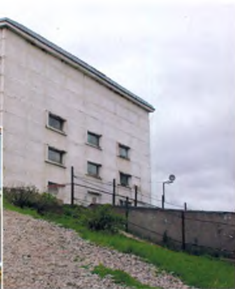
▲ ГЭС-31, г. Вытегра.
