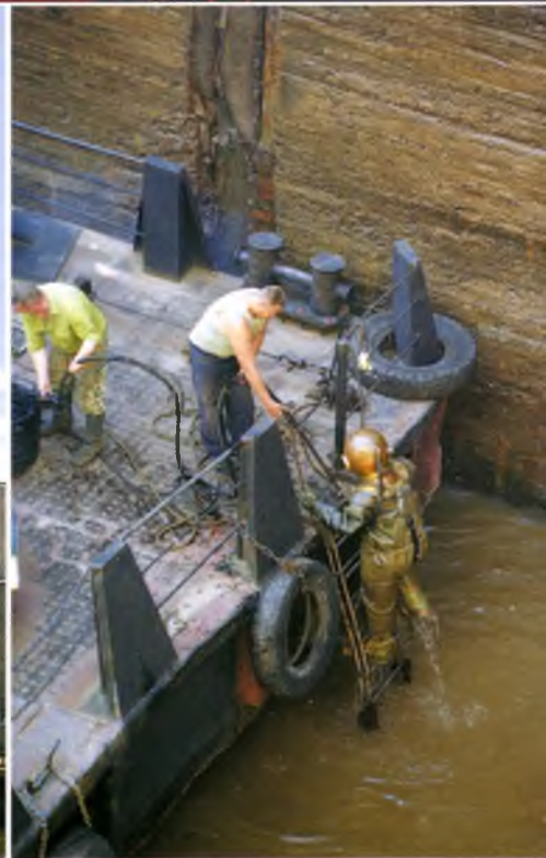
▲ Водолазные работы в камере шлюза № 5
