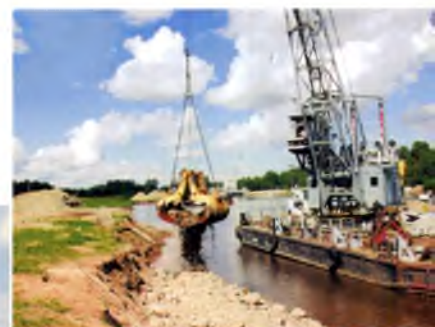
▼ Завершение работ по расширению судоходной трассы верхнего подходного канала шлюза № 5 земснарядом СЗ-209, 2004 г.
