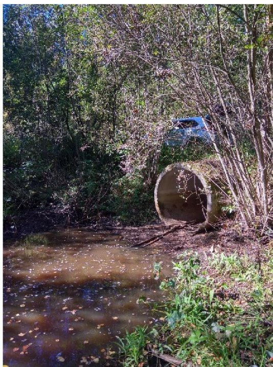
Труба в насыпи в конце лета
