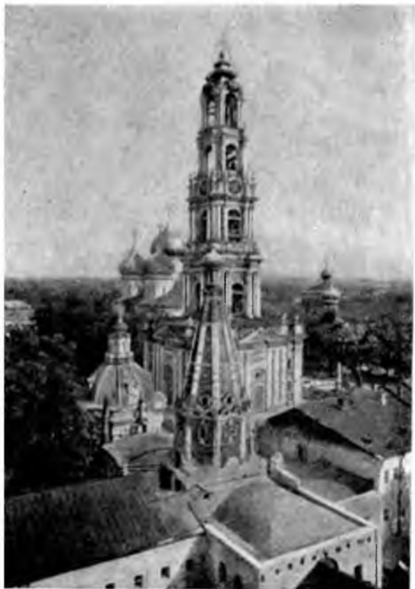
20. Общий вид реставрационных работ больничных палат в 1940 г.
