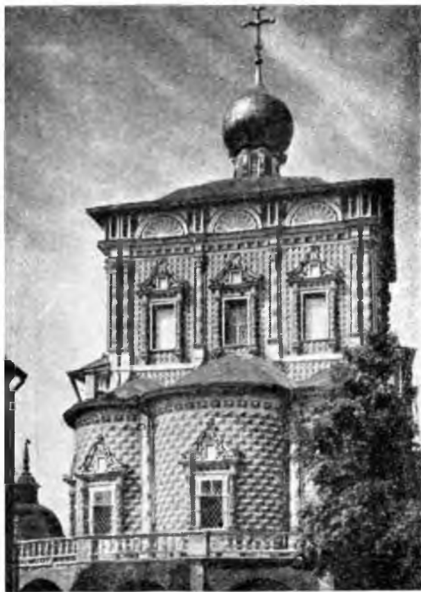
26. Восточный фасад трапезной (1686 — 1692 гг.)
