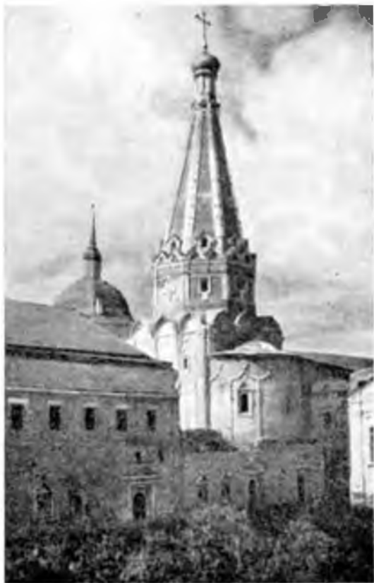
18. Комплекс больничных палат и церковь Эосимы и Савватия 1635 — 1637 гг. в состоянии реставрации
