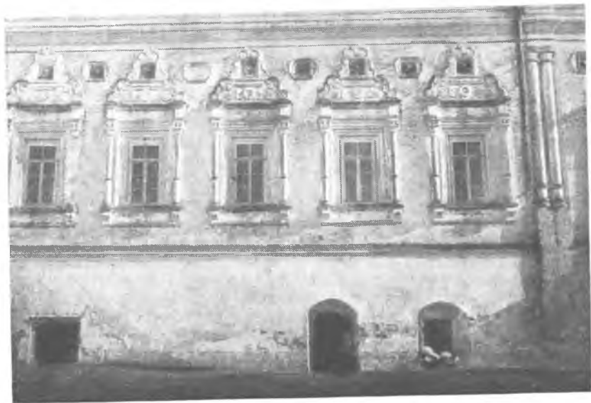
19. Я. Бухвостов. Солатчинский монастырь. Северный фасад трапезной
