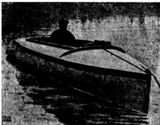
Рис. 37.— Наружный вид гоночной лодки небольших размеров, 8 метров, двигатель 24 л. с. Форма передней части корпуса приспособлена для наименьшего сопротивления не только воды, но и воздуха.
