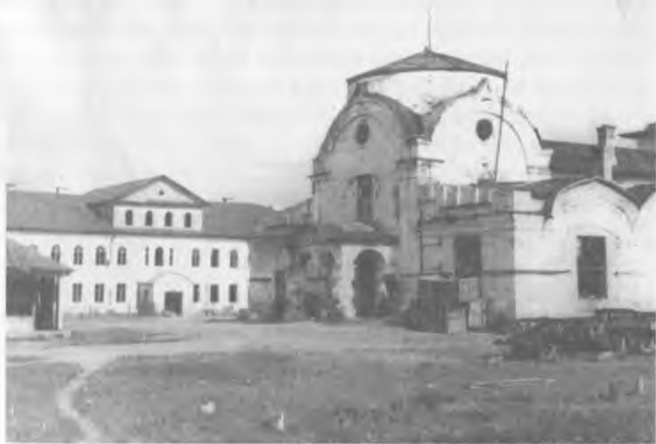
Вход в главный храм. Фото 9 сентября 1947 г.
