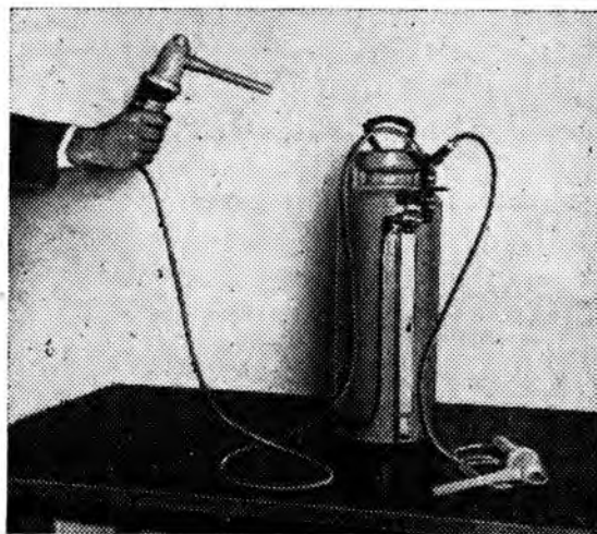
Рис. 2. Портативный аппарат для аэрозольной вакцинации зверей на мелких фермах
