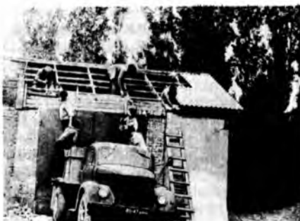
Члены Джувалинского районного общества кролиководов и звероводов-любителей (Джамбулская обл.) большинством производственных объектов возвели своими руками. На снимке: заканчивается строительство гаража
