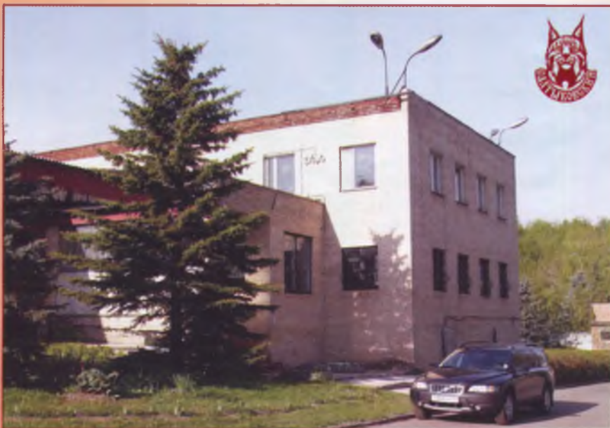
Здание забойного пункта
