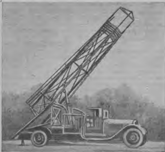
Рис. 4. Установка башни в вертикальное положение
