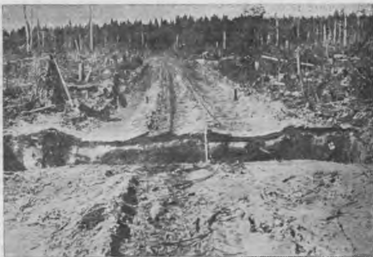
Рис. 4. Трелевка хлыстов арочными прицепами. Разрез трелевочного волока на супесчаной почве в ельнике-черничнике. Смешанный почвенный горизонт на поверхности волока и боковых валах. Микрорельеф на трелевочном волоке. Углубление дна волока за счет уплотнения почвы и образование насыпей (боковых валов).
