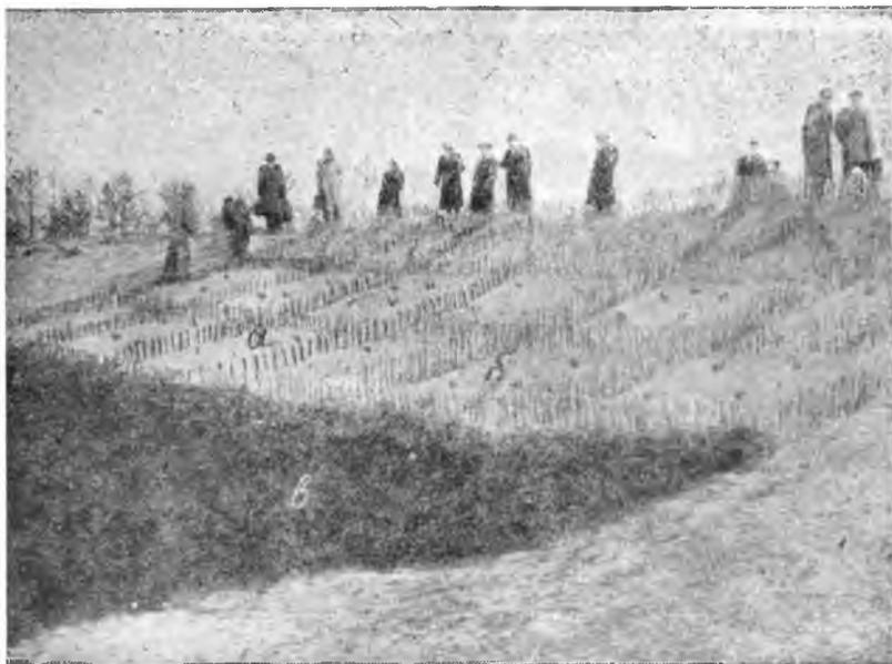
Типы механических защит, используемых при лесных культурах на песках: клеточные — из сосновых кольев (а) и из тростника (б); сплошные усти-
