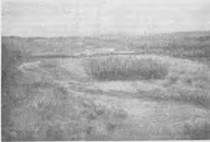
Рис. 4. «Живой» плетень, перегораживающий русло мелкого донного водотока. На середине его огромный куст шелюги, вызвавший разделение русла на два рукава (балка Хвалытьба)
