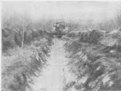
Рис. 2. Лесной канавокопатель ЛК-2 в работе.
