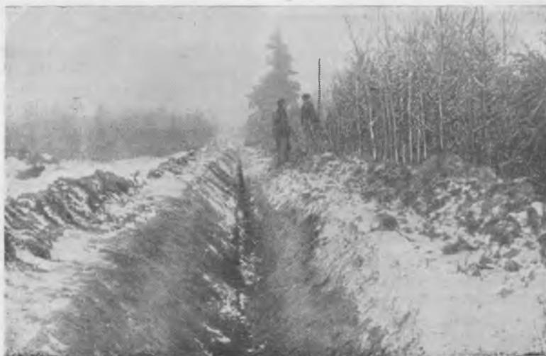
Рис. 8. Канавка, проложенная канавокопателем ЛКС-2.
