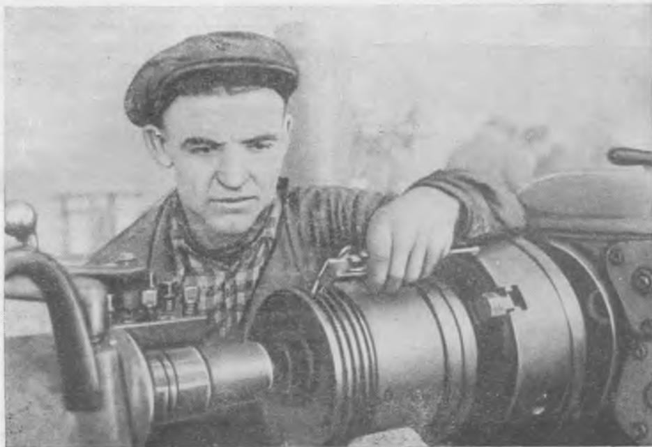
Орловская дубравная ЛЭС успешно выполнила план ремонта тракторов в IV квартале 1951 г. На снимке: токарь ЛЭС Б. Т. Гапоненко, выполняющий нормы на 200—250% ремонтирует поршень тракторного двигателя. (Фото А. Красильникова).
