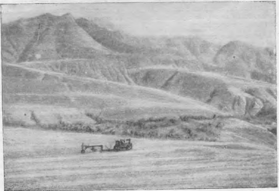
Рис. 1. Производство террасировочных работ на горном склоне
