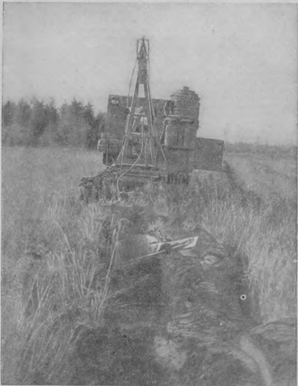
*Рис. 3. Лесной навесной плуг в работе.*
