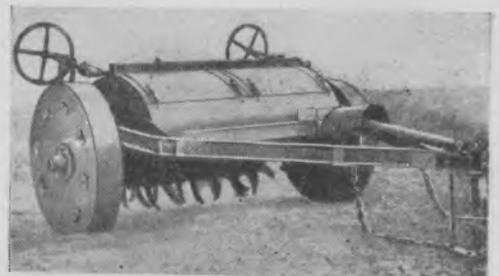
Рис. 5. Фреза болотная ФБ-1,0.
