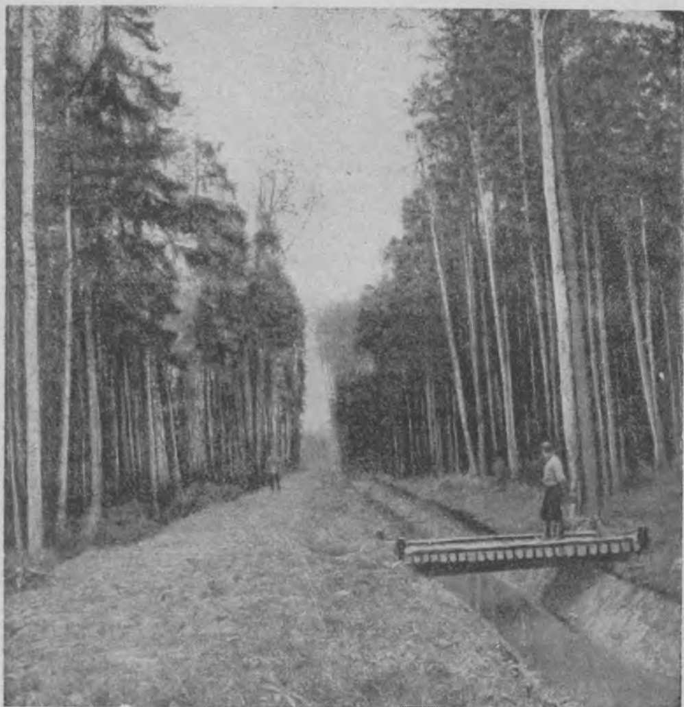
Рис. 6. Осушительный канал вдоль противопожарного разрыва. Видземская ММС.
