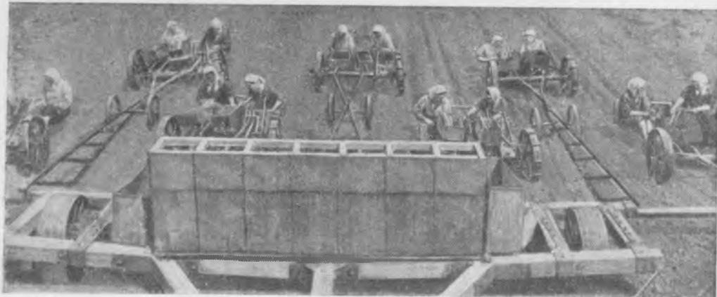
*Агрегат из семи лесопосадочных машин СЛЧ-1 в работе.*
