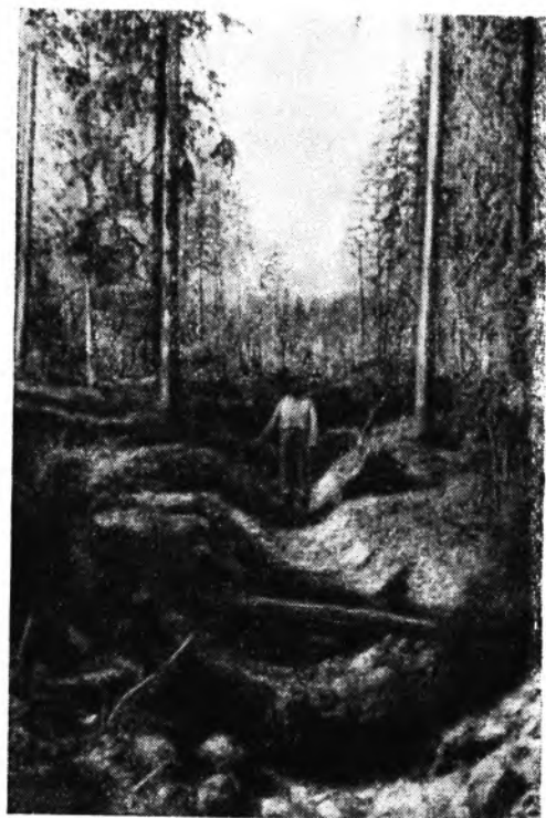
Осушительная канава, проложенная взрывным способом.
