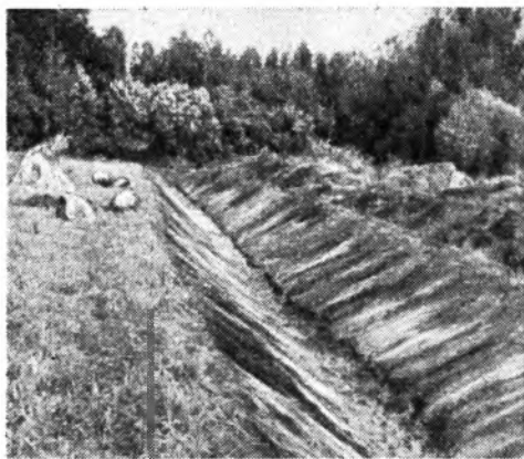
Рис. 2. Экскаваторная канава с ручной отделкой откосов. Рижская ММС.
