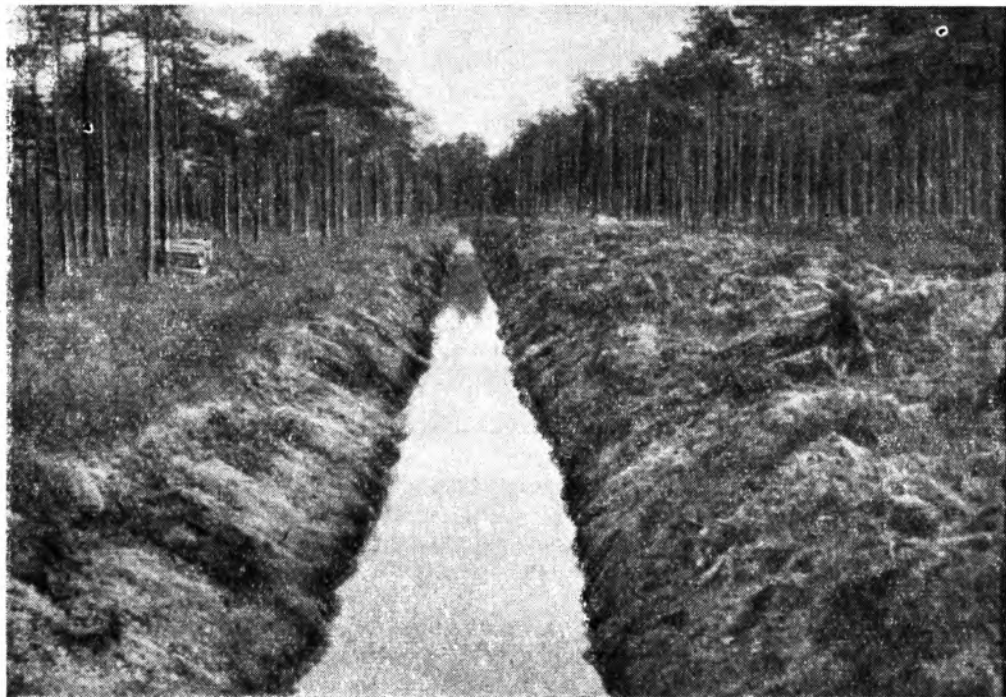
Рис. 3. Магистральный канал осушительной сети. Рижская ММС.
