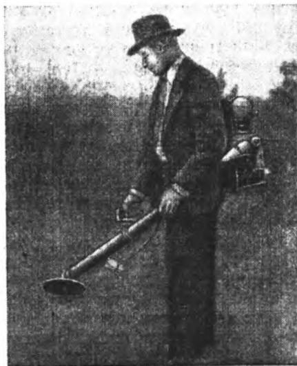
*Рис. 2. Механический инструмент для срезки кустарников и мелких деревьев (США).*
