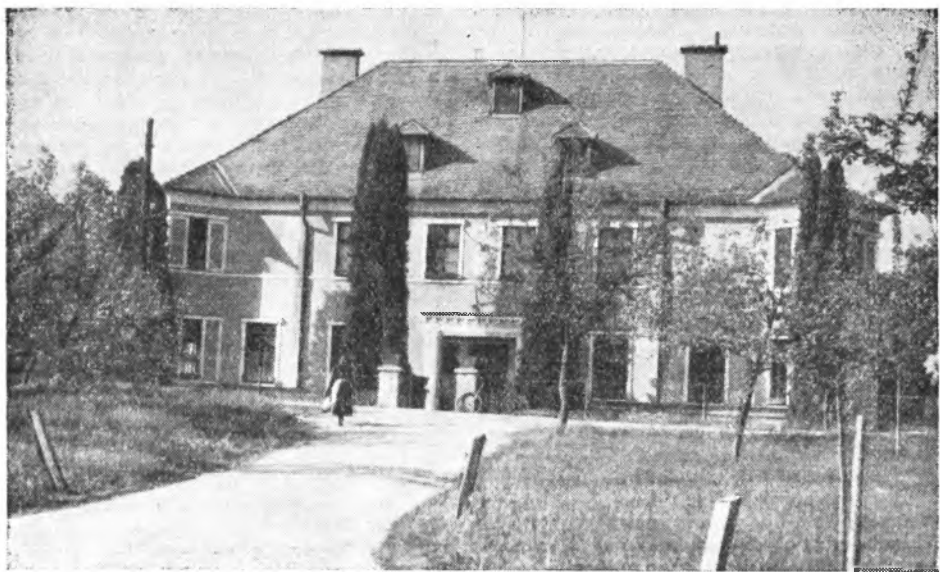
Здание лесхоза „Топольчанки“. Перед ним деревья пирамидальной формы западной туи.
