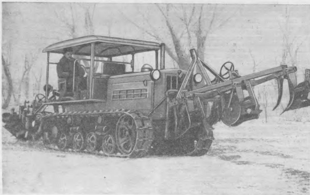
Рис. 4. Трактор ДТ-57 с плугом-рыхлителем ПРГ-3-4.
