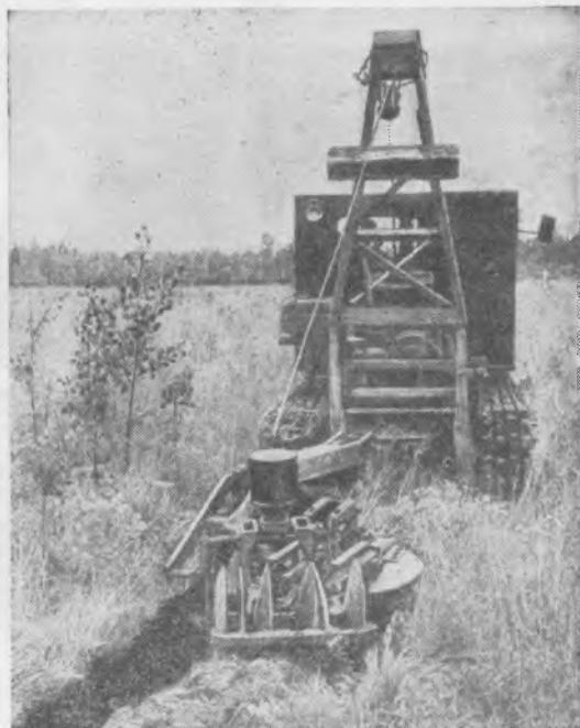
Рис. 2. Одноотвальный плуг лесной навесной комбинированный ПЛН-53/63.
