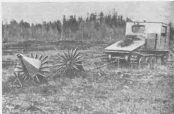
Рис. 3. Агрегат якорных покровосдирателей в работе.
