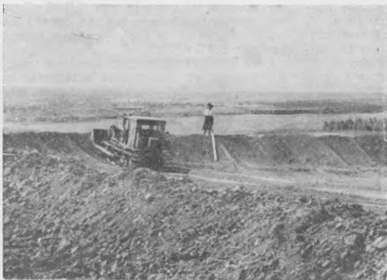
Перемещение грунта в тело вала бульдозером Д-159-Б.
