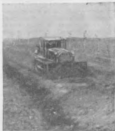
Трамбовка и разравнивание вала бульдозером Д-159-Б.
