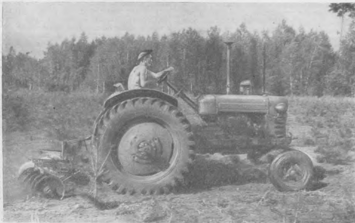
Навесной дисковый культиватор, изготовленный в Колтубанском механизированном лесхозе.
