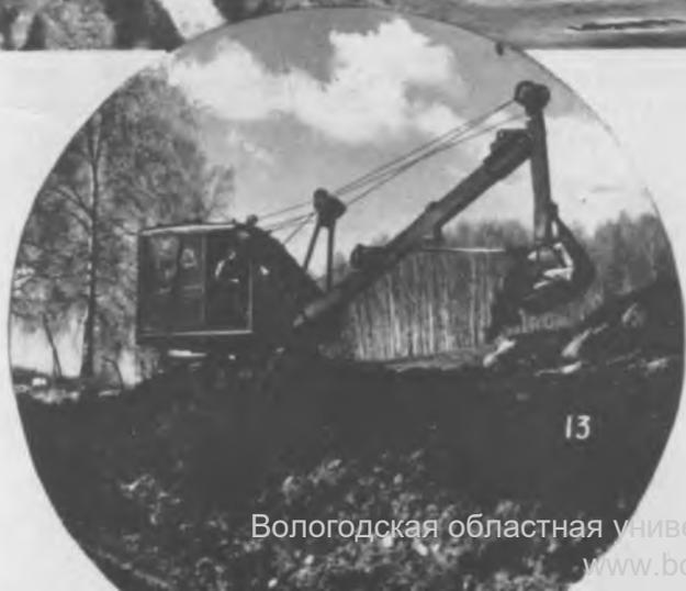
11. Раскорчевка пней на трассе канала корчевателем-собирателем Д-210Б в Тирельском лесничестве Ригас-Юрмалского леспромхоза.
