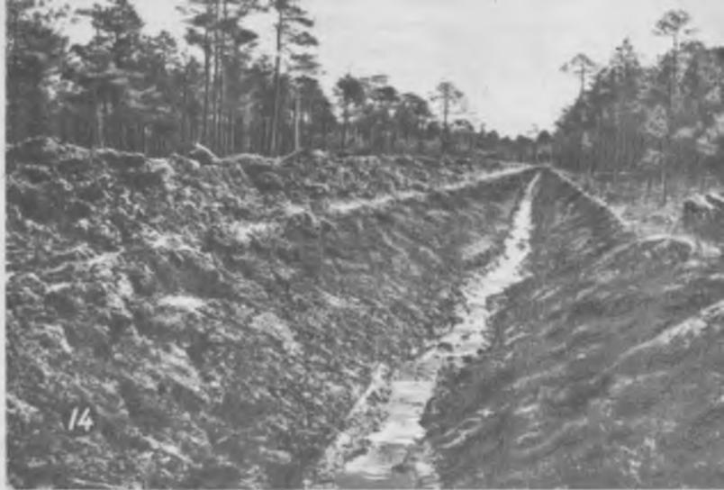
14. Канал, вырытый экскаватором Э-352 в сосняке сфагновом. Звиргздесское лесничество Вецумнисского леспромхоза.
