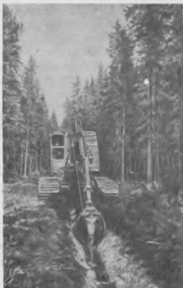
*Устройство канала экскаватором Э-352 с профильным ковшом.*
