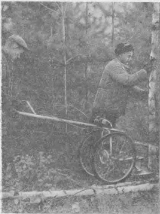
Рис. 2. Работа с передвижной моторизованной пилой ПМП-1 по осветлению сосново-березовых культур в Пушкинском механизированном лесхозе (Московская область).
