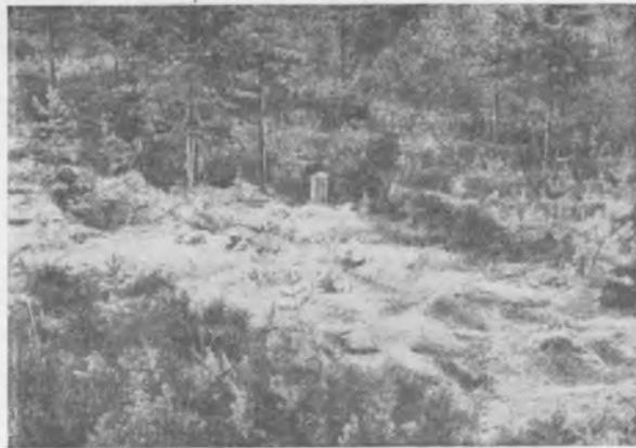
Рис. 2. Заградительная полоса из минерализованного покрова, созданная взрыванием 200-граммовых патронов аммонита, расположенных на расстоянии 3 м друг от друга.
