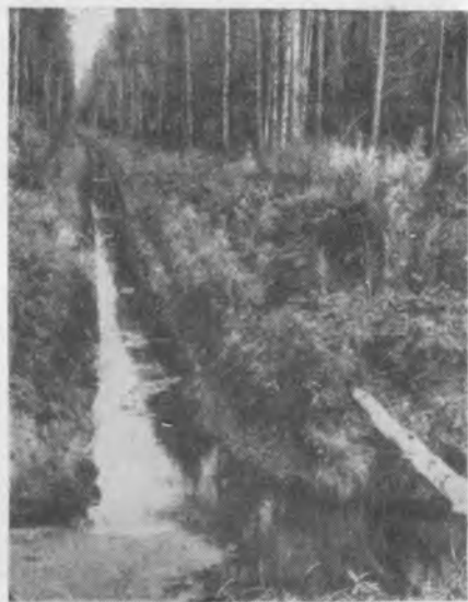
Коллектор при впадении в магистральный канал
