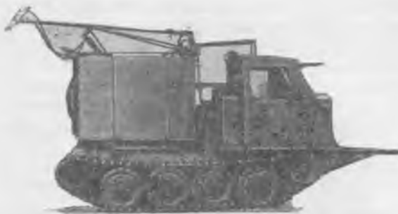
Рис. 5. Опрыскиватель конструкции ЛенНИИЛХ (И. М. Загорский), смонтированный на трелевочном тракторе ТДТ-40.
