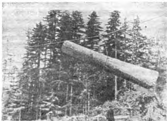
Спуск бревна трособлочной установкой.
