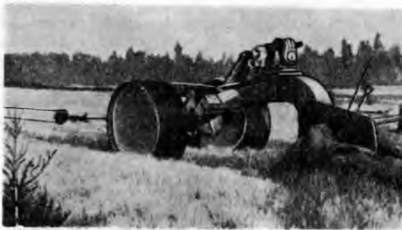
Плуг для устройства магистральных каналов (вид сбоку).
