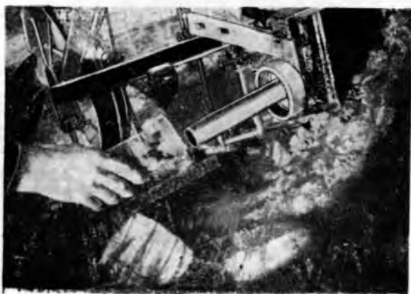
Установка пыльника на ось колеса.
