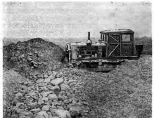
Перемещение грунта бульдозером для устройства вала террасы.
