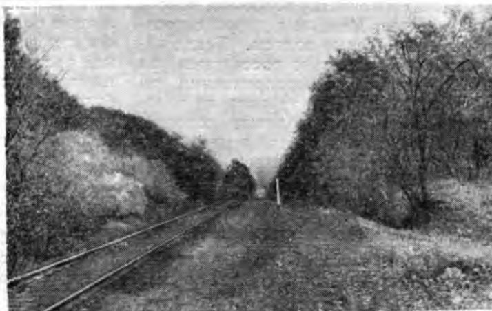
Противооползневые насаждения акации белой на откосах железнодорожной выемки.
