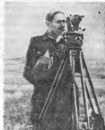
Старший инженер-землеустроитель М. П. Кеслер (в настоящее время пенсионер) измеряет теодолитом угол поворота трассы лесной полосы. 1949 г.
