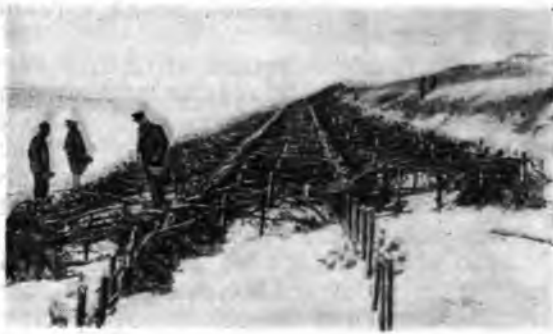
Укрепление передового вала, подмываемого морем в северной части Куршской косы.
