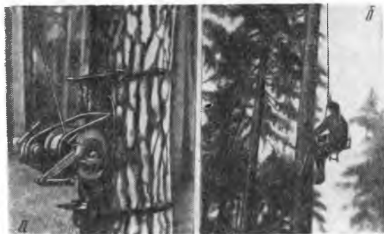
Рис. 9. Ручная лебедка для подъема сборщика (а). Подъем лебедкой в крону дерева (б).
