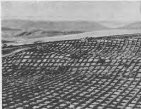
Защищенный ветрорезами участок полотна железной дороги Баотоу — Ланчжоу.
