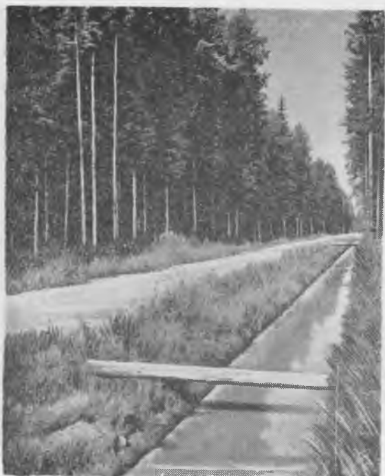
Рис. 8. Переходы через канаву, устроенные для пешеходов.
