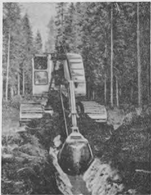
Рис. 4. Экскаватор Э-352 с профильным ковшом конструкции Пятини на подготовке осушительной канавы.
