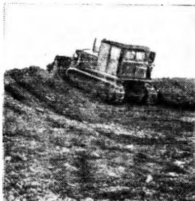
Отсыпка водозадерживающего вала бульдозером
