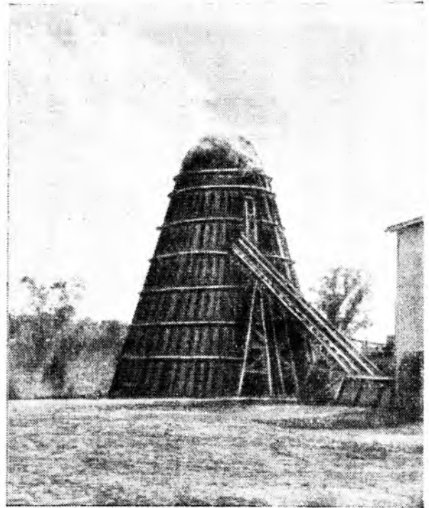
Рис. 8. Печь для сжигания лесных отходов.
