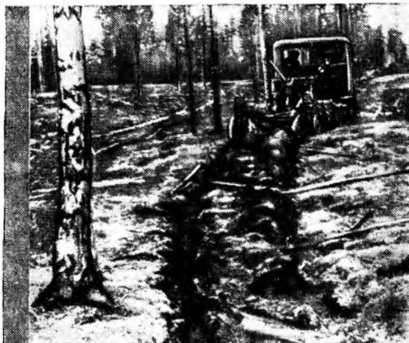
Рис. 4. Покровосдиратель-сеялка ПСТ-2А в работе.
