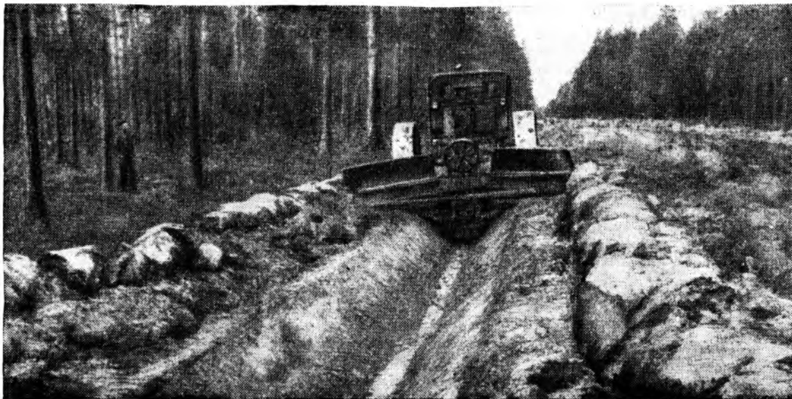
Рис. 6. Канавокопатель ЛКА-2 в работе.
