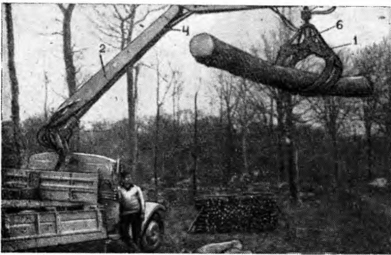
Рис. 2. Погрузчик, смонтированный на автомашине.
