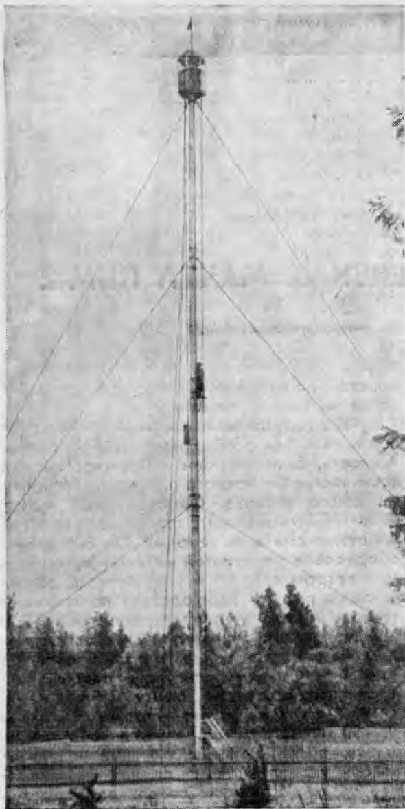
Рис. 1. Пожарная наблюдательная мачта ПНМ-2.
