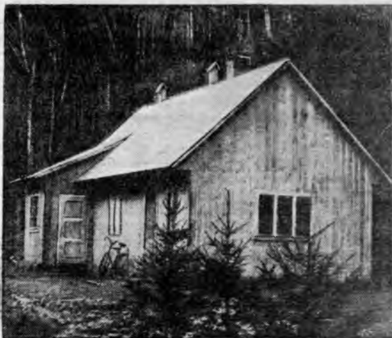
Рис. 1. Здание форелевого инкубатора в Велико-Бычковском лесхозе.
