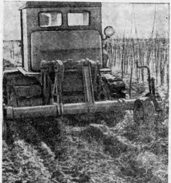
Рис. 4. Плуг ВРН-2 в работе на выкопке сеянцев.
