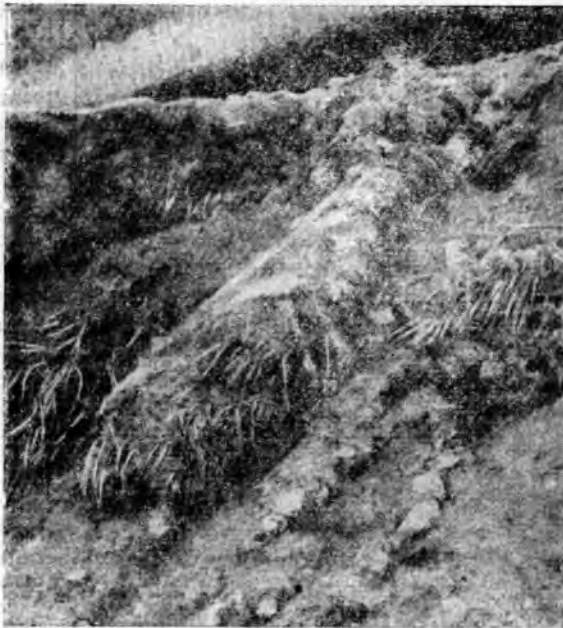
Рис. 6. Размыв насыпной части террасы при нарезке в период, предшествовавший летним ливням 1959 года.
