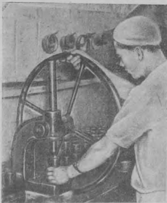
Рис. 3. Выпрессовка штырей ручным реечным прессом.
