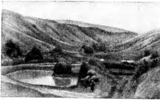
Рис. 2. Мелкие запруды по дну оврагов на Клетском опытно-овражном пункте.
