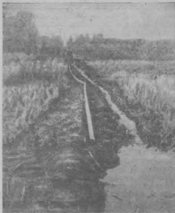
Подготовка шнурового заряда к очередному взрыву.
