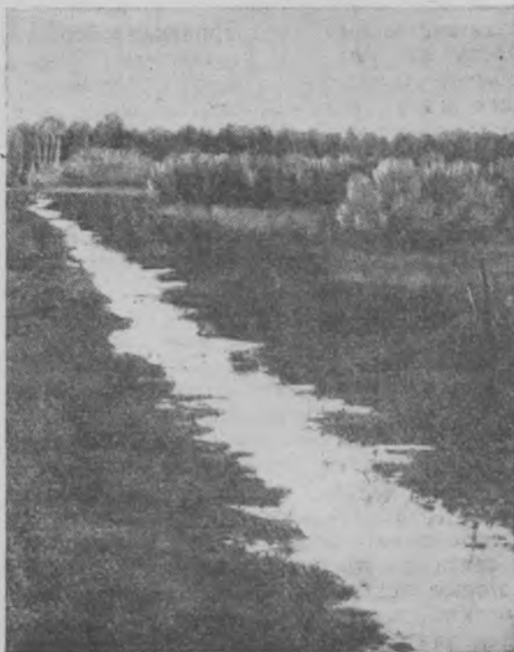
Рис. 2. Вид канавы, созданной при помощи взрывов шнуровым методом.
