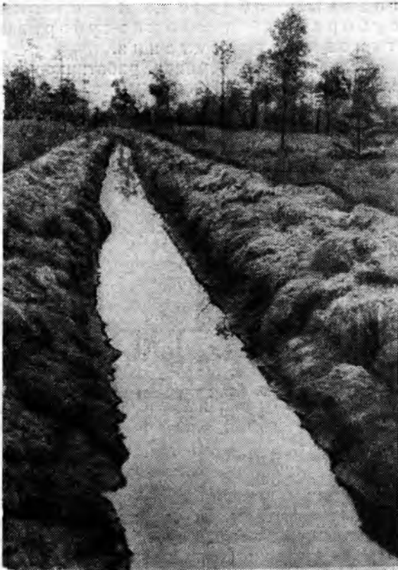
Канал, вырытый за 1 проход канавокопателем КЛК-1000 в торфе глубиной более метра. Вырицкий лесхоз (Ленинградская область).
