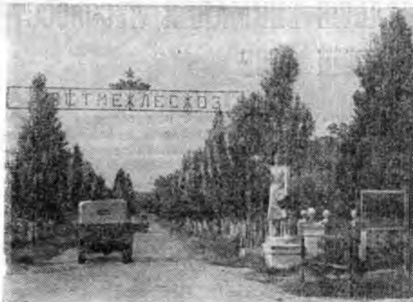
Оформление главного подъезда к Ростовскому мехлесхозу.
